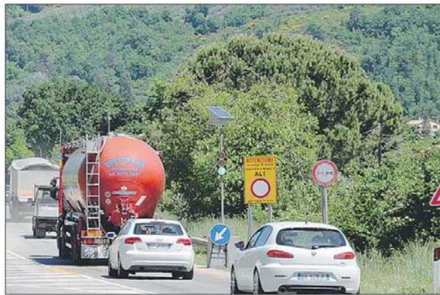
Lavori fermi Sulla Flaminia resta il senso unico alternato perché secondo l'Anas l'intervento richiesto non è di sua competenza
