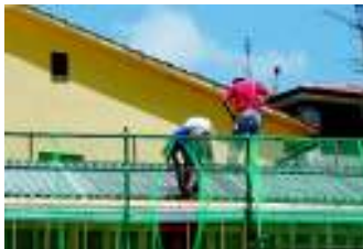
➤➤ Operai edili al lavoro
